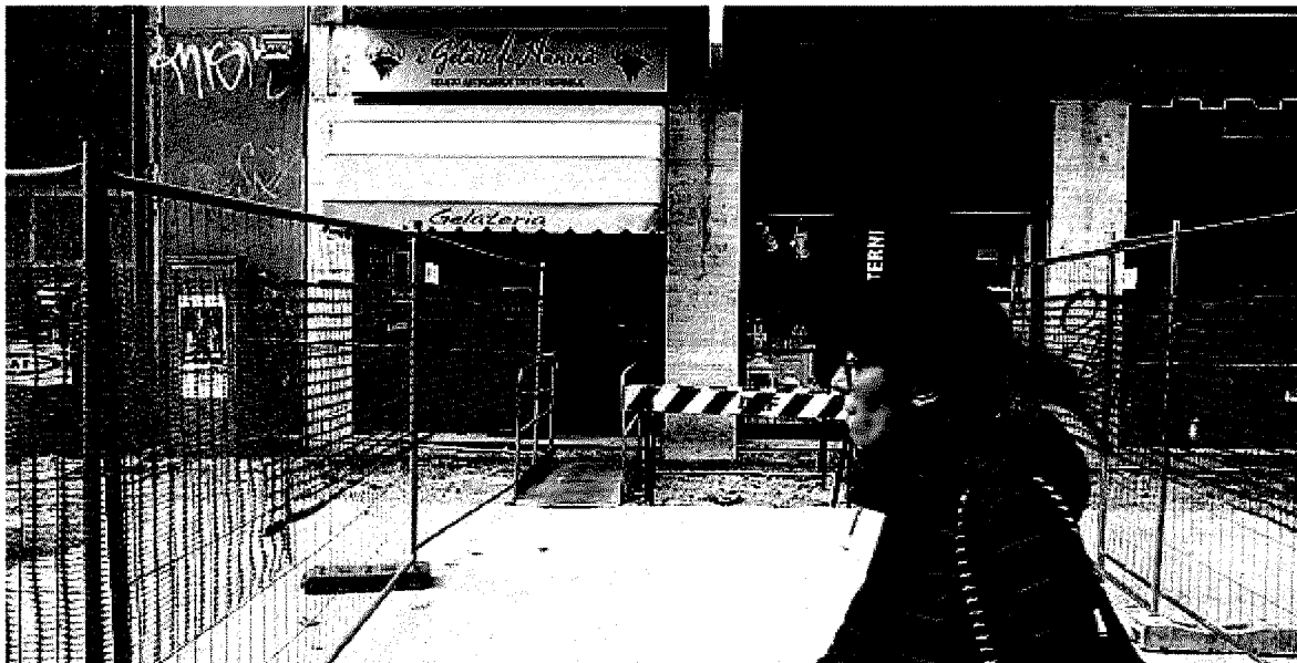
ISOLATI La gelateria Naninà di via Foppa 52 con il cantiere a pochi centimetri di distanza (Newpress)
