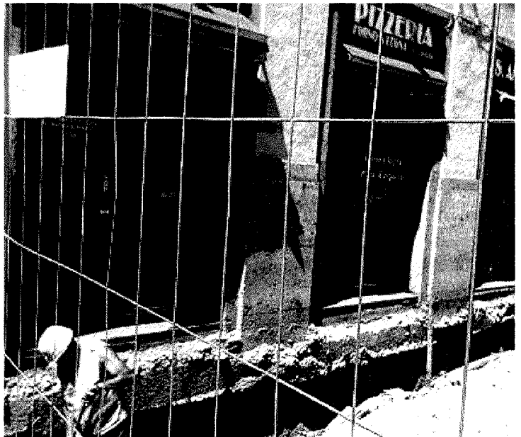
SOS Il tratto di via Foppa 10 dove i cantieri sono attaccati alle vetrine delle attività, lo stesso problema si era presentato ai civici 48-50
