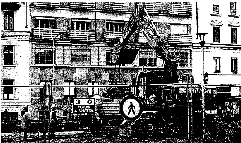
LAVORI AL VIA I cantieri della linea 4 della metropolitana a Solari
