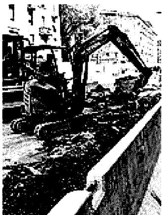
Scavi Sopra, i lavori per la linea blu del metrò lungo via Foppa (Fotogramma). A sinistra, la libreria «Bistrò del tempo ritrovato» al civico 4, che chiuderà a causa dei cantieri
