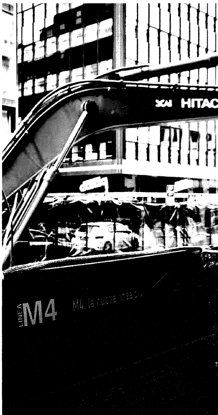
Gru in corso Europa per i lavori del metrò 4
