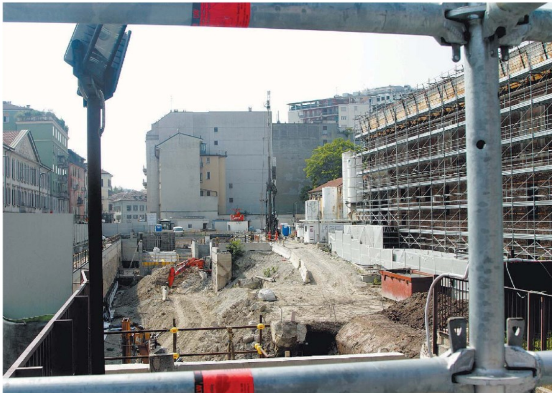
Il cantiere M4 alla fermata Sforza-Policlinico: nonostante la vicinanza con M3, non è previsto un tunnel di collegamento per i passeggeri
