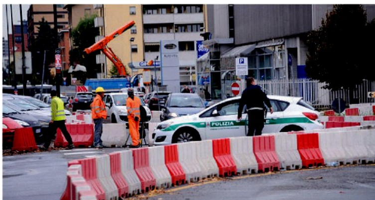
Disagi ieri al cantiere M1 in via Gramsci a Sesto San Giovanni
