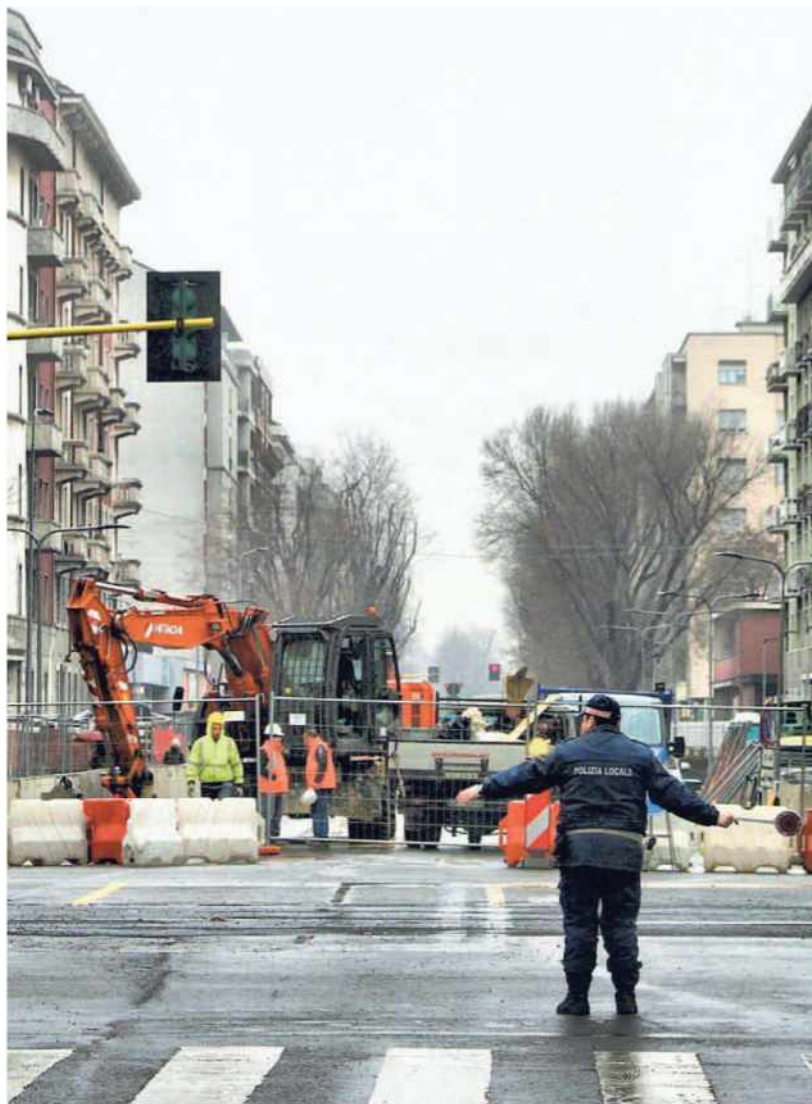
I nuovi divieti di circolazione scattati in via Foppa. A sinistra, la zona del futuro cantiere in via Sforza
